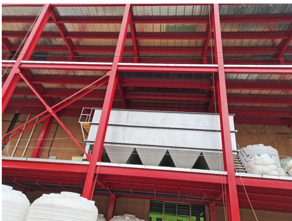
废水处理设施
